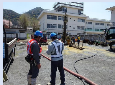
地中熱交換器施工状況
