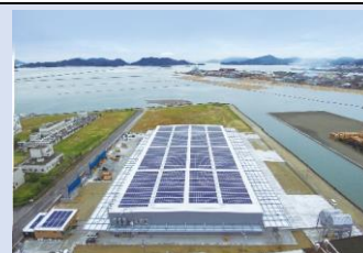
福山工場 上空写真
